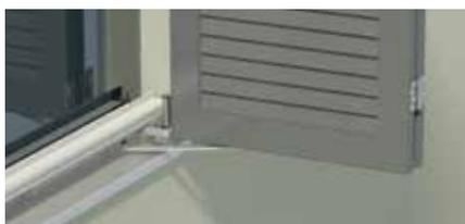
Protection contre la torsion excessive à l'intérieure
